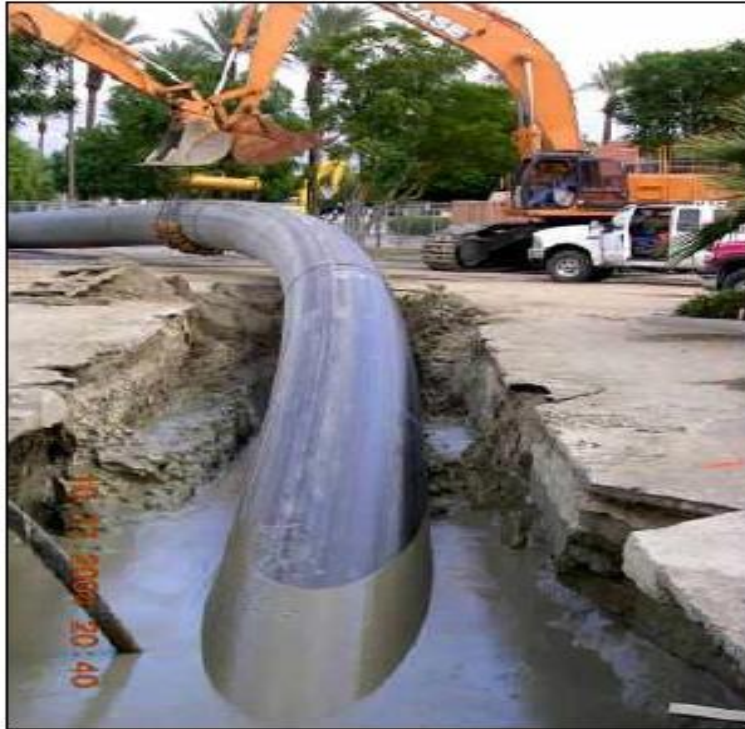
Fig. 1. 54" PE Pipe, Indio, CA.
